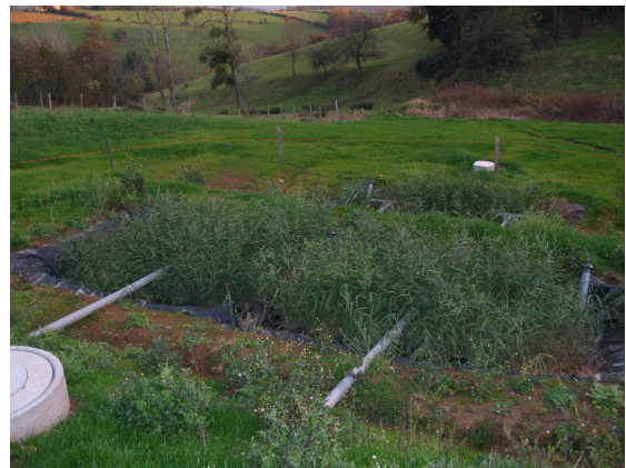
Filtres plantés de roseaux agricoles
