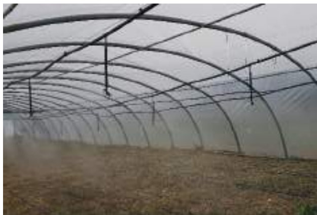
Brumisation dans le tunnel
